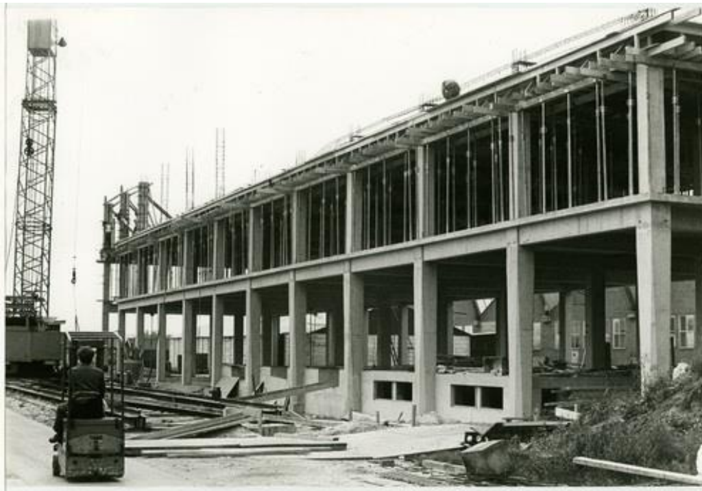
Foto van de bouw van het kantoor van de aluminiumverpakkingen-industrie Boxal in 1960 (bron: https://onderzoek.veenendaal.nl/ )
