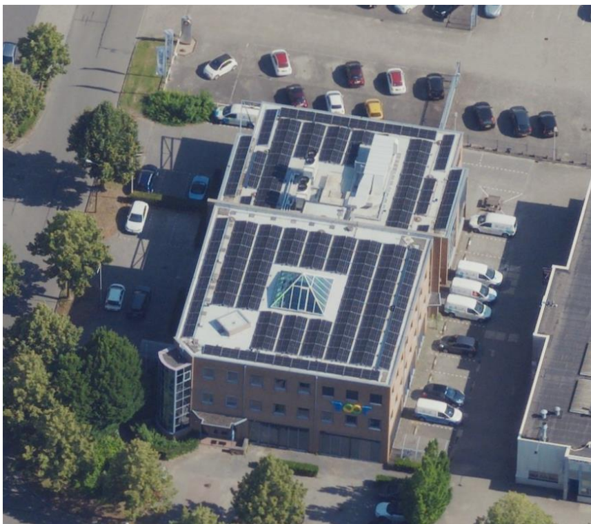
Figuur 4-4: praktijkvoorbeeld koele daken i.c.m. zonnepanelen
