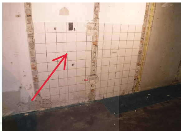
Asbesthoudende tegellijm
