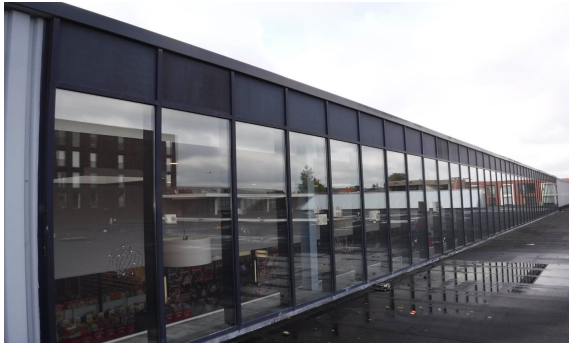
Panelen niet asbestverdacht
