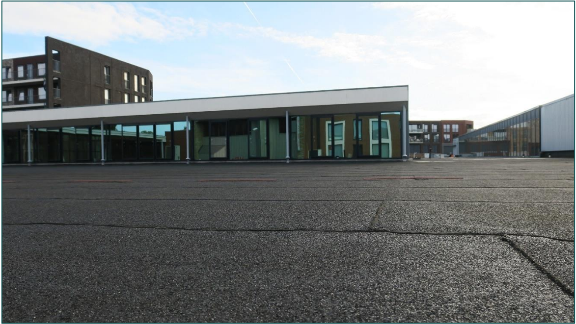
Figuur 3 Het dak van de bebouwing bestaat uit een plat bitumen dak.
