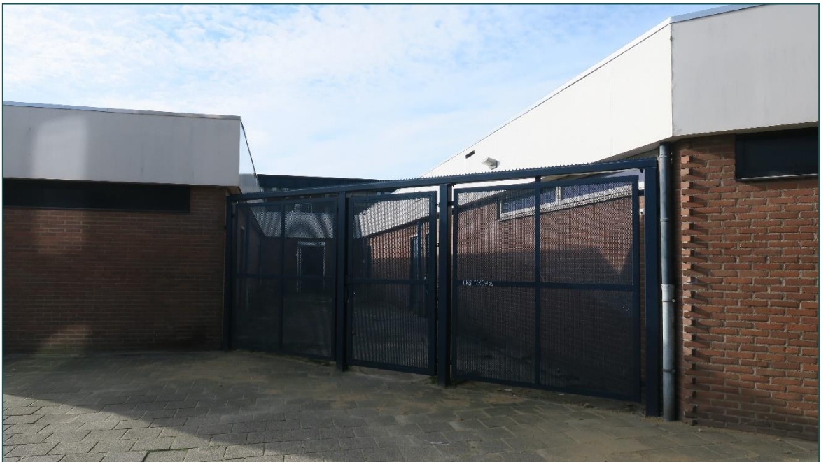
Figuur 4 De planlocatie is volledig verhard ende bebouwing beschikt over een boeiboord en daklijsten.
