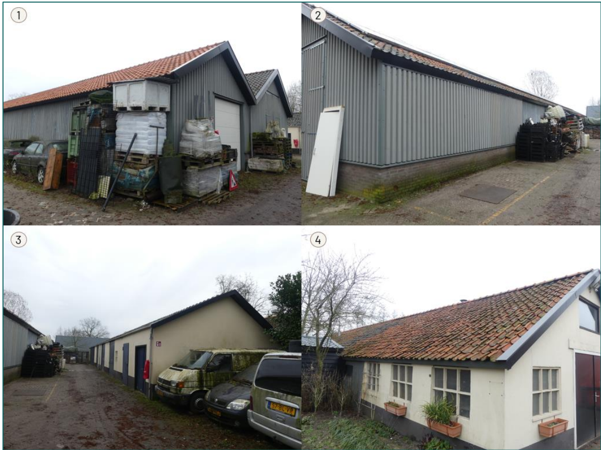
Figuur 1.3 Op de planlocatie is men voornemens om 4 opstallen te slopen.
