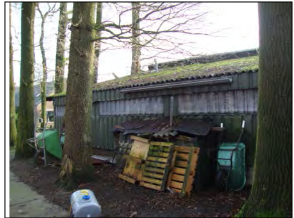
Foto 08 (aggregaat onder overkapping)
