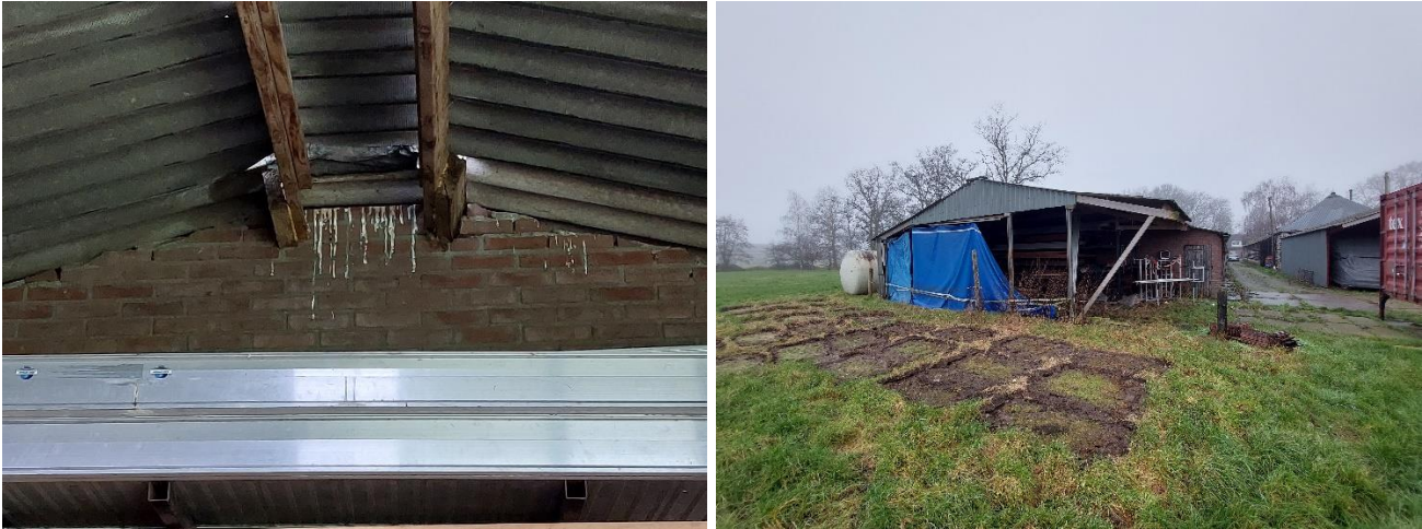
Figuur 20. Bevindingen steenuilonderzoek. Foto links: Mestsporen van vermoedelijk steenuil in de schuur op het perceel van Nederwoudseweg 66/68. Foto rechts: Schuur op het erf van Nederwoudseweg 66/68 waar steenuilen waar mestsporen van vermoedelijke steenuil zijn aangetroffen.
