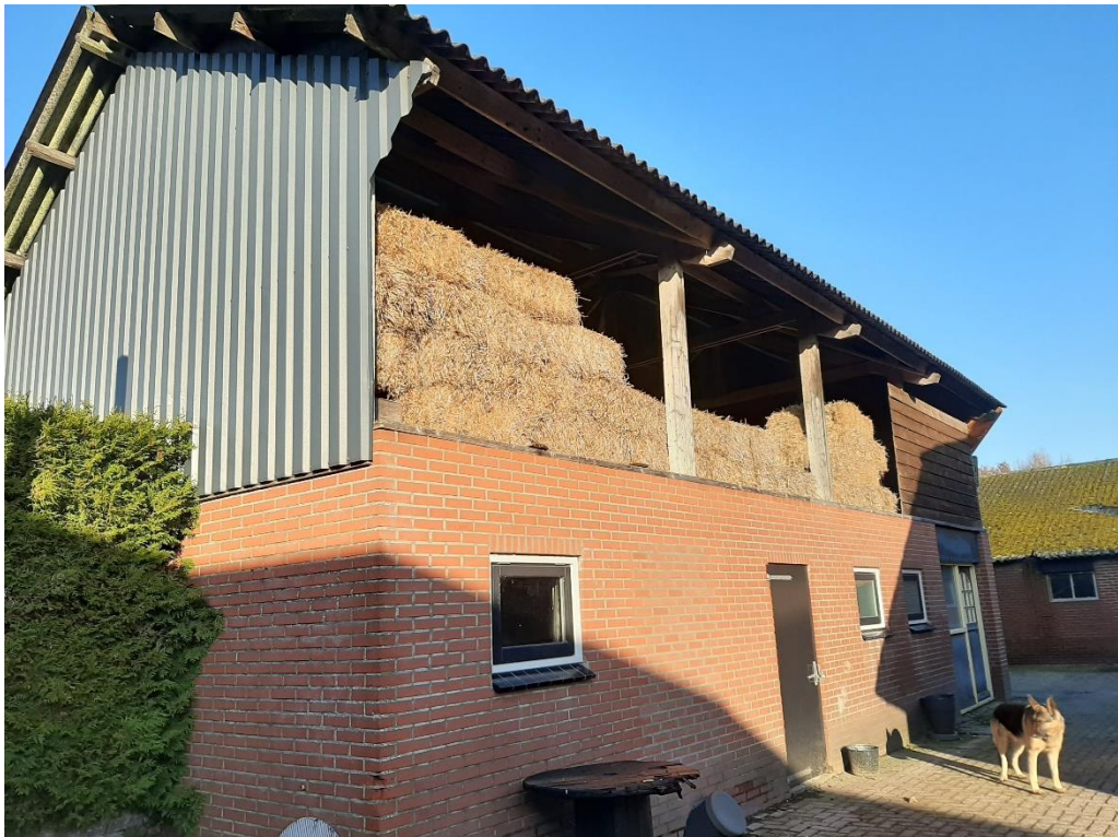
Figuur 2 Schuur B.
