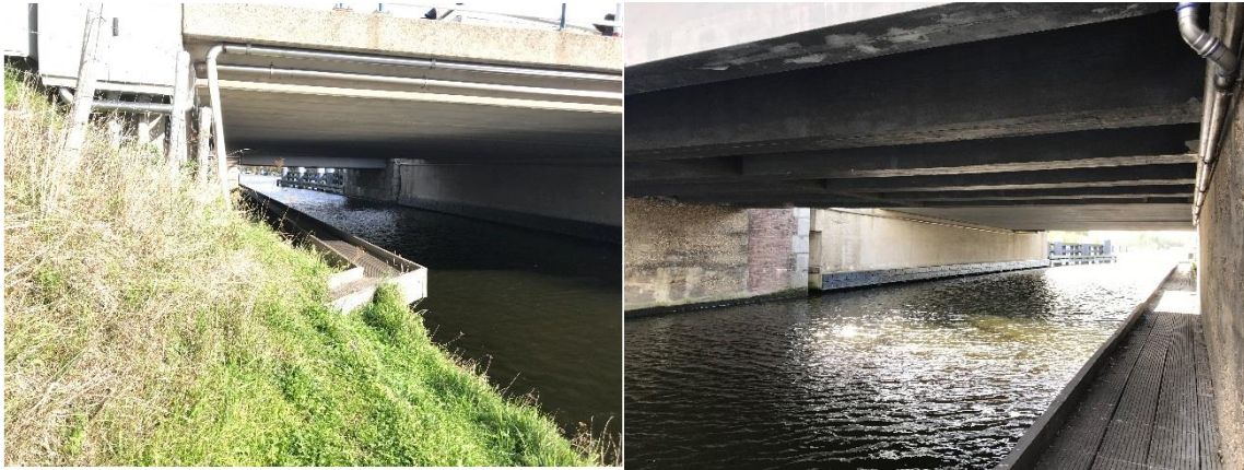
Afbeelding 5.3 In de huidige staat betreft de looprichel betreft een open houten loopplank
