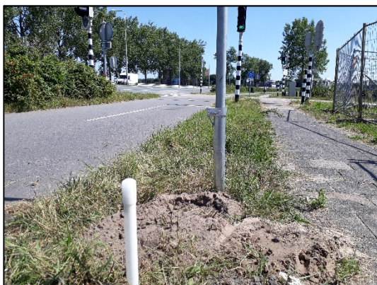
Foto 5: Geplaatste peilbuis boring 02
