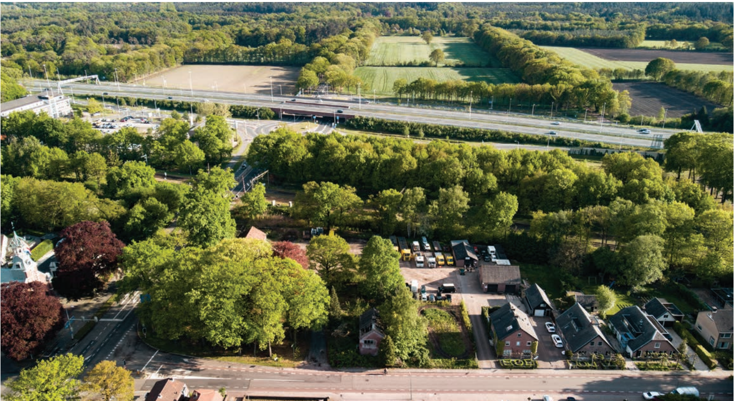
Huidige situatie Tuindorppweg met aan de linkerzijde de kerk
