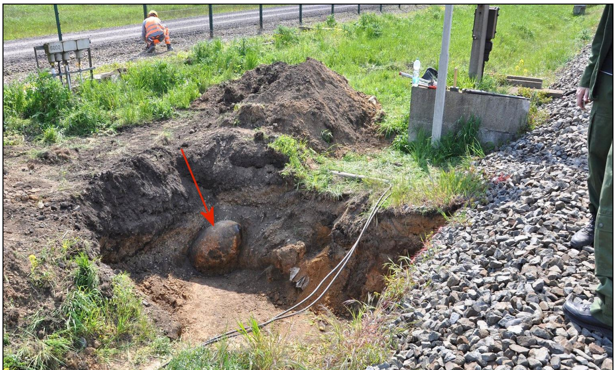
Figuur 36: Ligging van een blindganger van een brisantbom op nauwelijks 75cm diepte langs een spoorbaan.
