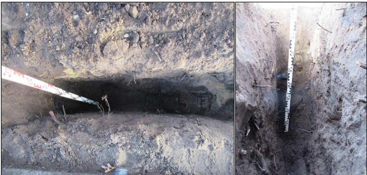
Foto links: proefsleuf bovenaanzicht onder trottoir 4 meter ten noorden van boom 418
