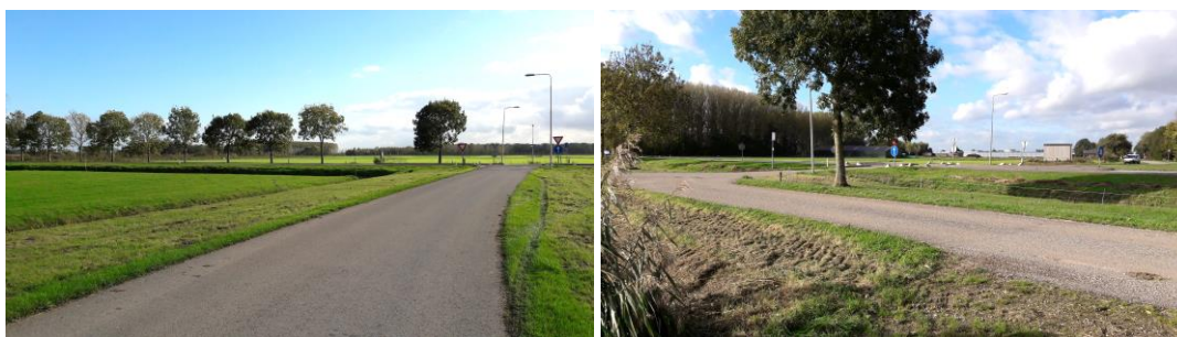
Figuur 1.3 Links: zicht op het kruispunt, gezien vanaf de Startweg in zuidelijke richting. Rechts: zicht op het kruispunt vanaf de Elskampseweg in noordwestelijke richting.
