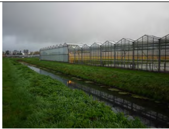
Foto 4: Kassencomplex vanaf de westzijde
