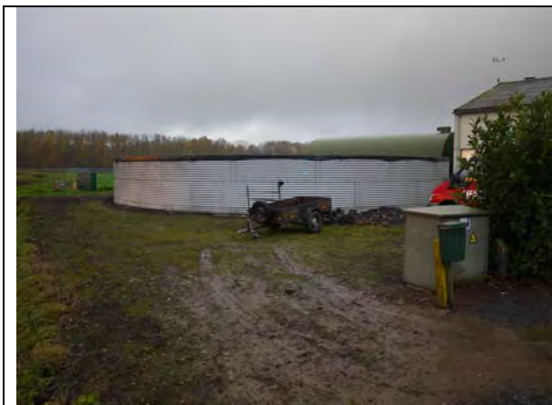
Foto 1: Hemelwaterbassin zuidzijde Molenkampsweg 15
