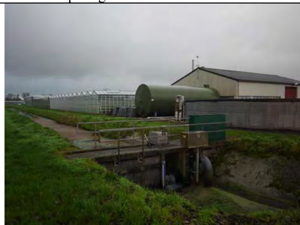
Foto 3: Kassencomplex vanaf de zuidwestzijde
