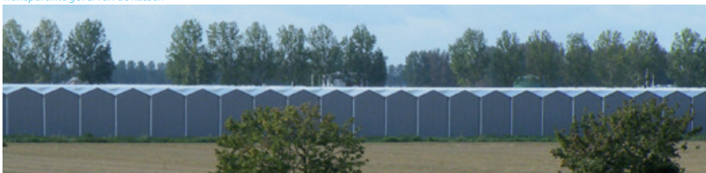
Afscherming door niet-transparante gevel van de kassen
