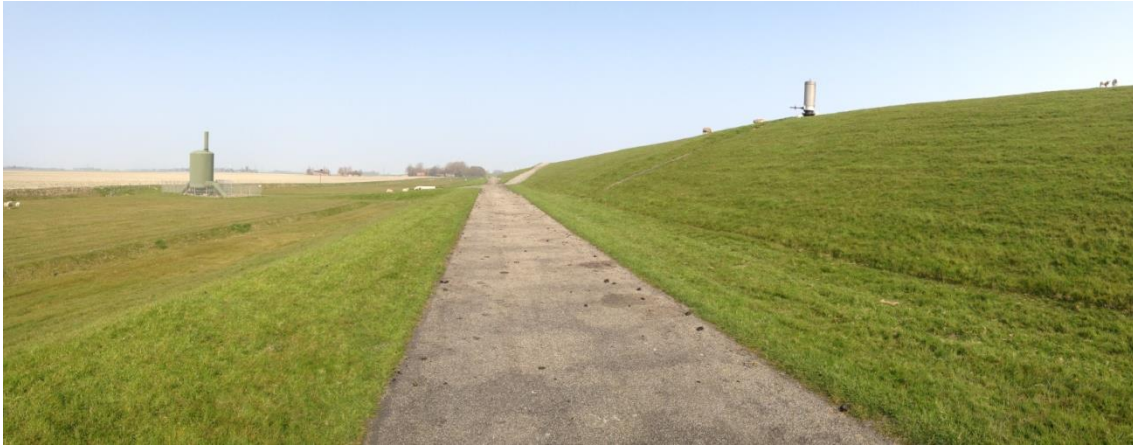
Afbeelding 3.6: zichtbare voorzieningen VKA-leiding
