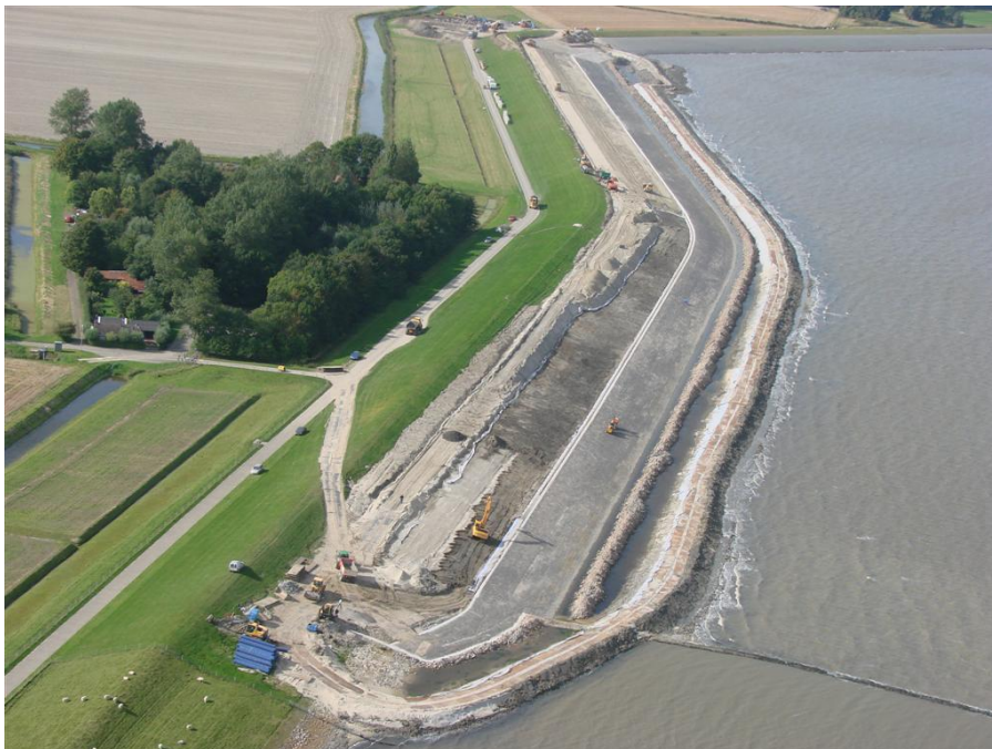
Foto 1 Voorbeeld buitendijkse werkstrook (dijkverbetering Nieuwstad, 2009)
