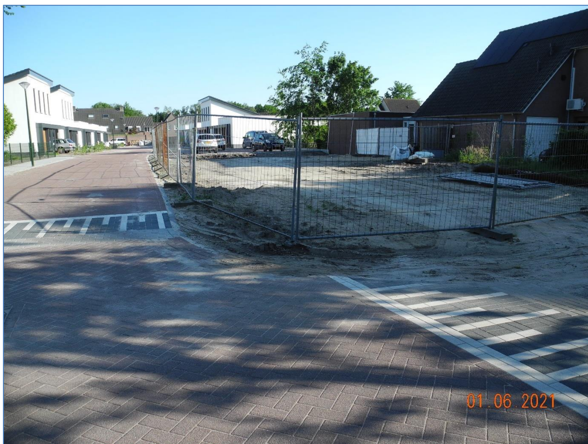
Foto huidige situatie (bron: opdrachtgever de heer Jansen)
