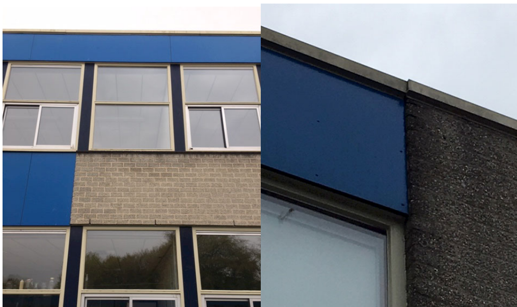
Links: Deel van de voorzijde van het gebouw. Rechts: detail van bovenverdieping met trespabeplating en dakrand.
