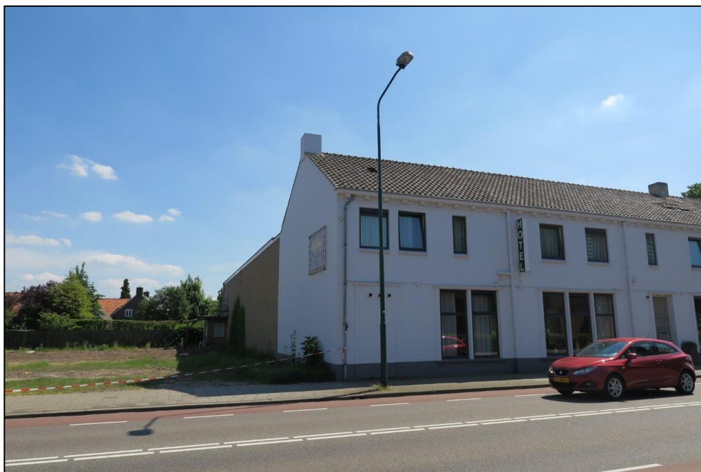
Figuur 1 De naastgelegen bebouwing aan de Spoorstraat 74.
