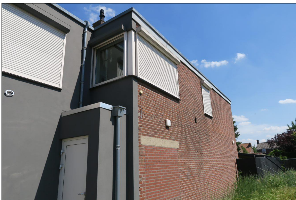
Figuur 3 De bebouwing aan de Spoorstraat 70 beschikt eveneens niet over open stootvoegen en/of kieren onder de daklijsten.
