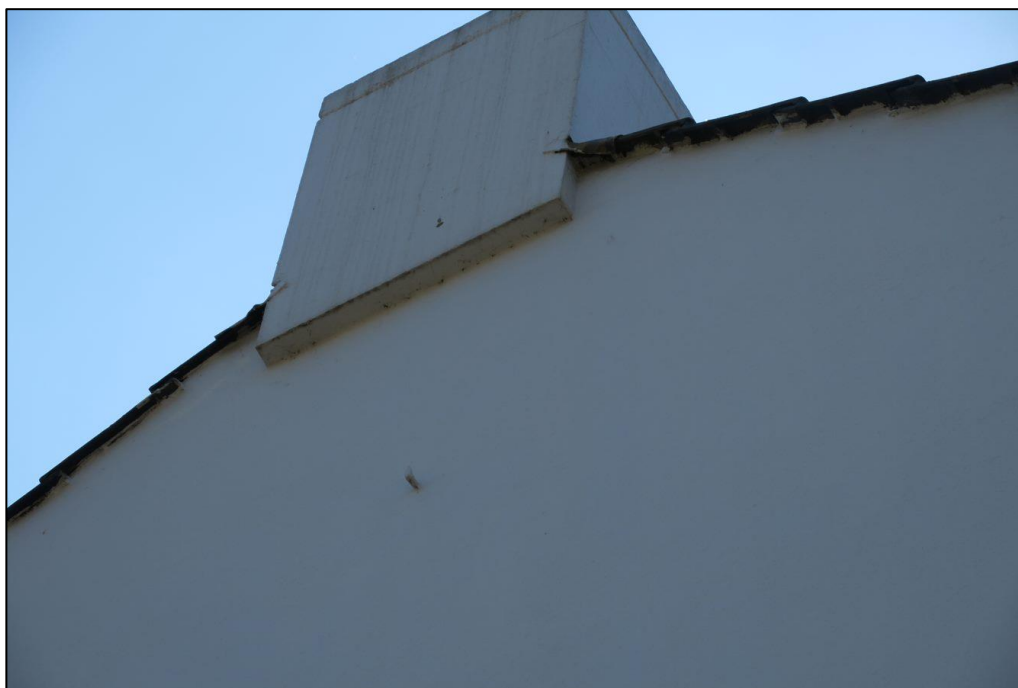
Figuur 2 De witte gestucte muur van de Spoorstraat 74 beschikt niet over openingen zoals open stootvoegen en kierende kantpannen.
