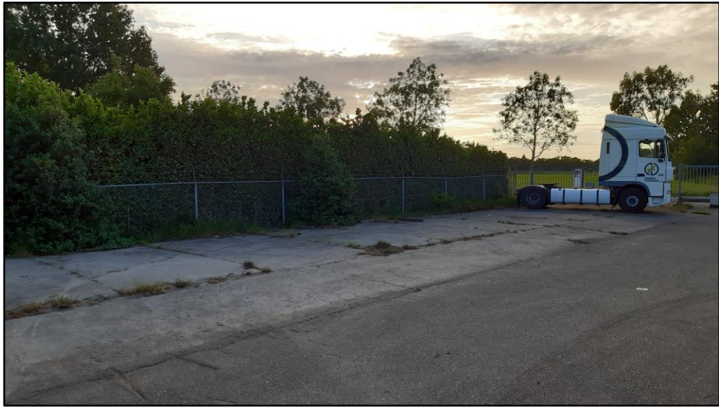
Figuur 3 Overzicht van de verharding en het hekwerk op de planlocatie.
