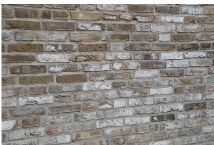
Vlakken met lichte bakstenen met kleine kleurverschillen, dieptewerking en ruimte voor bijzondere elementen zoals ingemetselde netskasten, luifels, huisnummers en begroeiing
