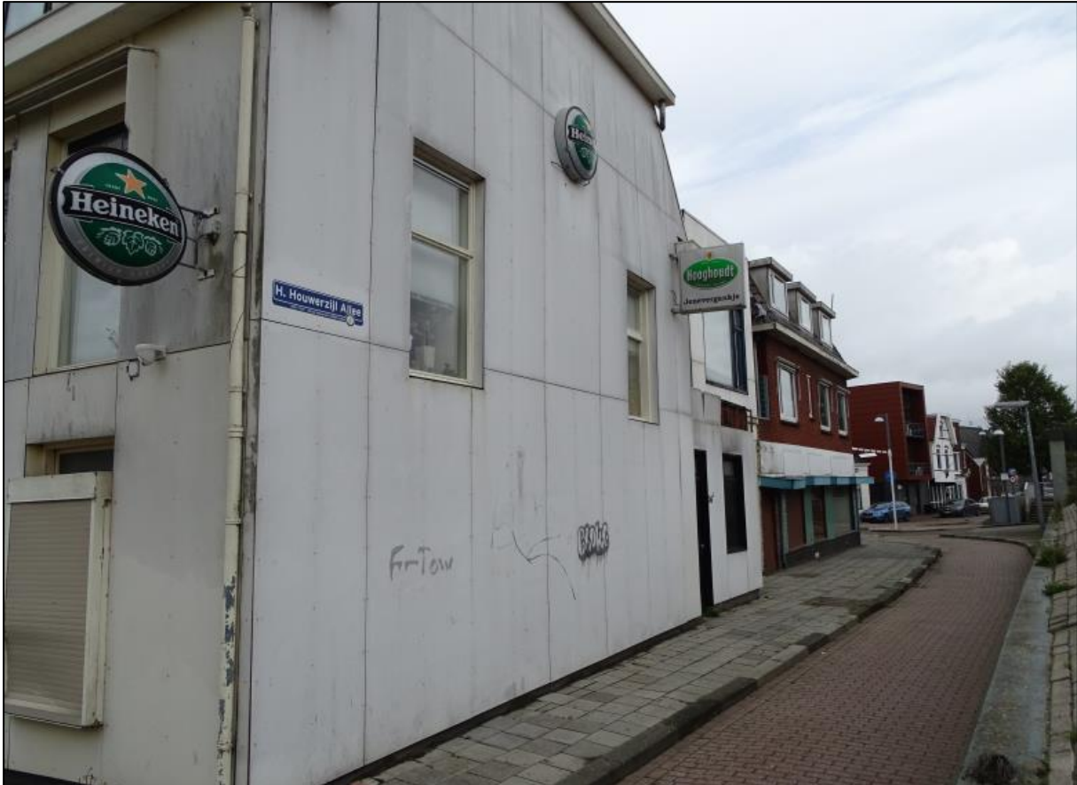
Figuur 2.21. Overzichtsfoto van het Jenevergangetje, gezien in noordoostelijke richting.
