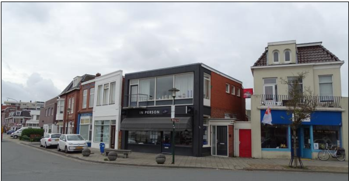
Figuur 2.26. Panden aan de Eemskanaal Noordzijde, gezien in noordwestelijke richting.
