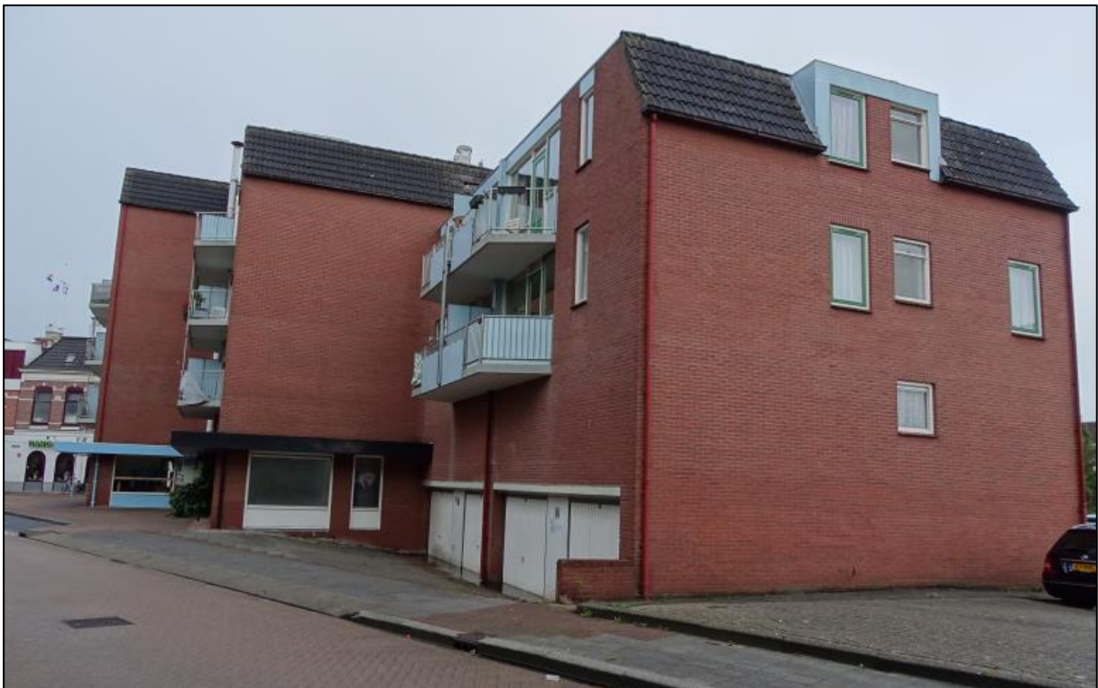
Figuur 2.7. Wooncomplex met enkele winkels, gezien in zuidelijke richting.
