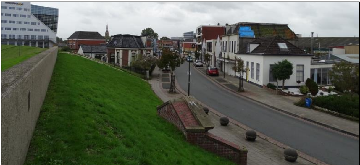
Figuur 2.24. Overzichtsfoto van de Nieuweweg, gezien van de dijk in zuidelijke richting.
