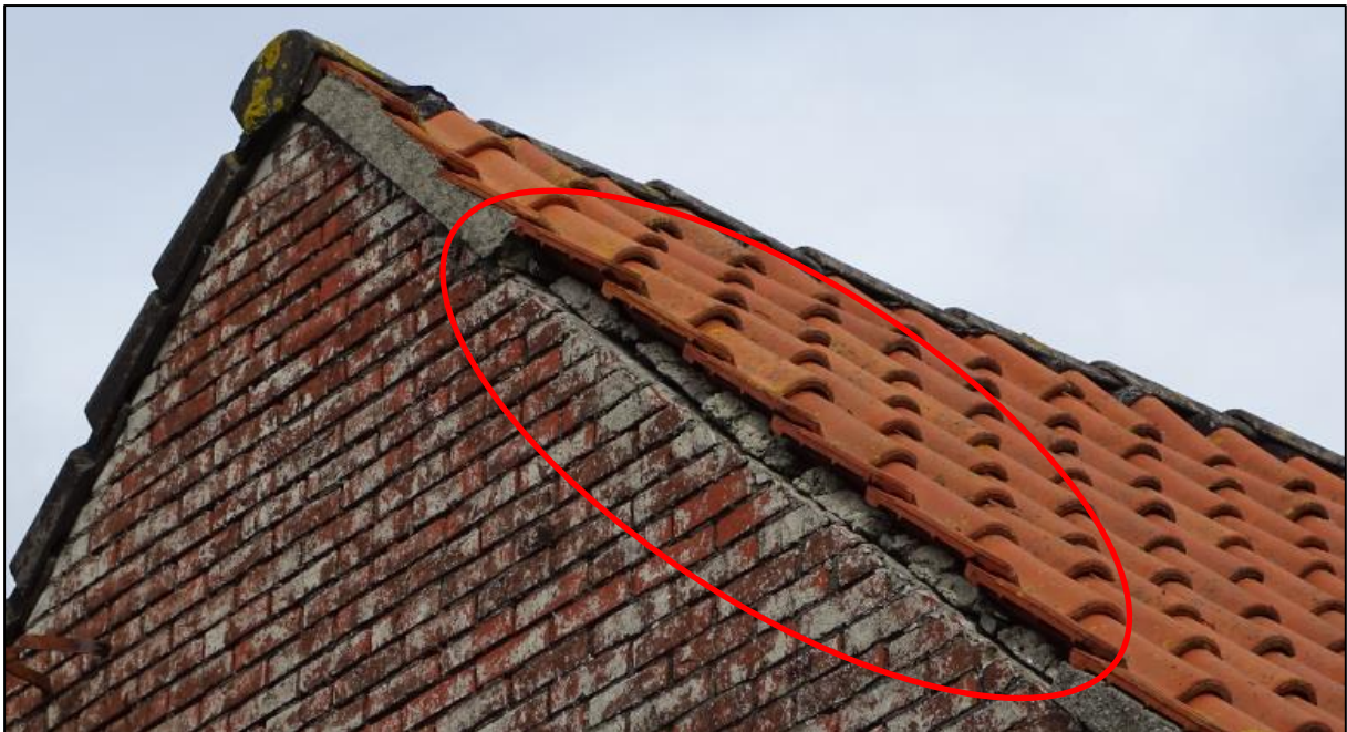
Figuur 5.25. Woning aan de E.H. Roggenkampweg waar ruimte onder de kantpannen aanwezig is.
