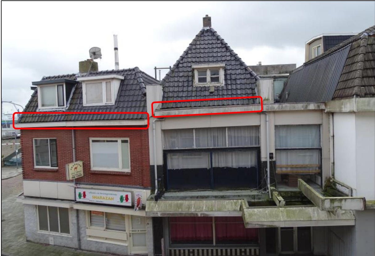
Figuur 5.9. Geschikte nestlocaties voor huismussen onder de eerste rijen met dakpannen.
