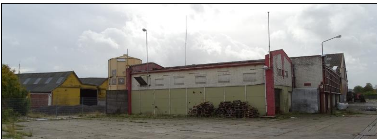
Figuur 2.31. Overzichtsfoto van het Ubbens terrein van enkele vervallen gebouwen en loodsen, gezien in zuidwestelijke richting.
