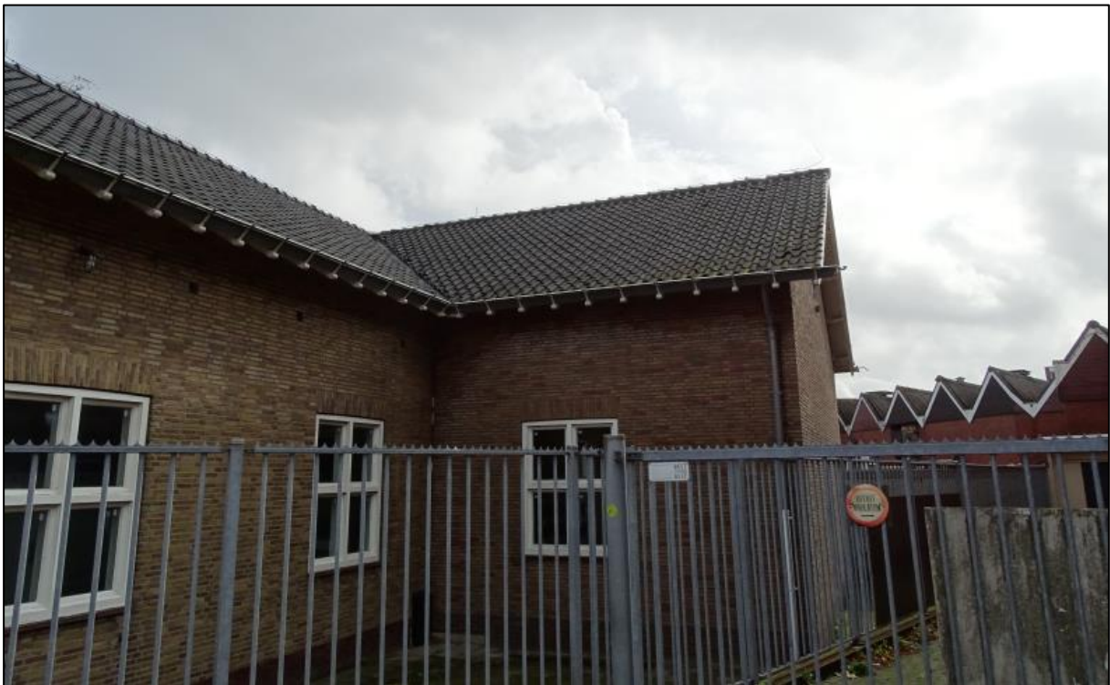
Figuur 2.16. Pand van de KPN met op de achtergrond de achterzijde van De Molenberg en De Bolder, gezien in oostelijke richting.
