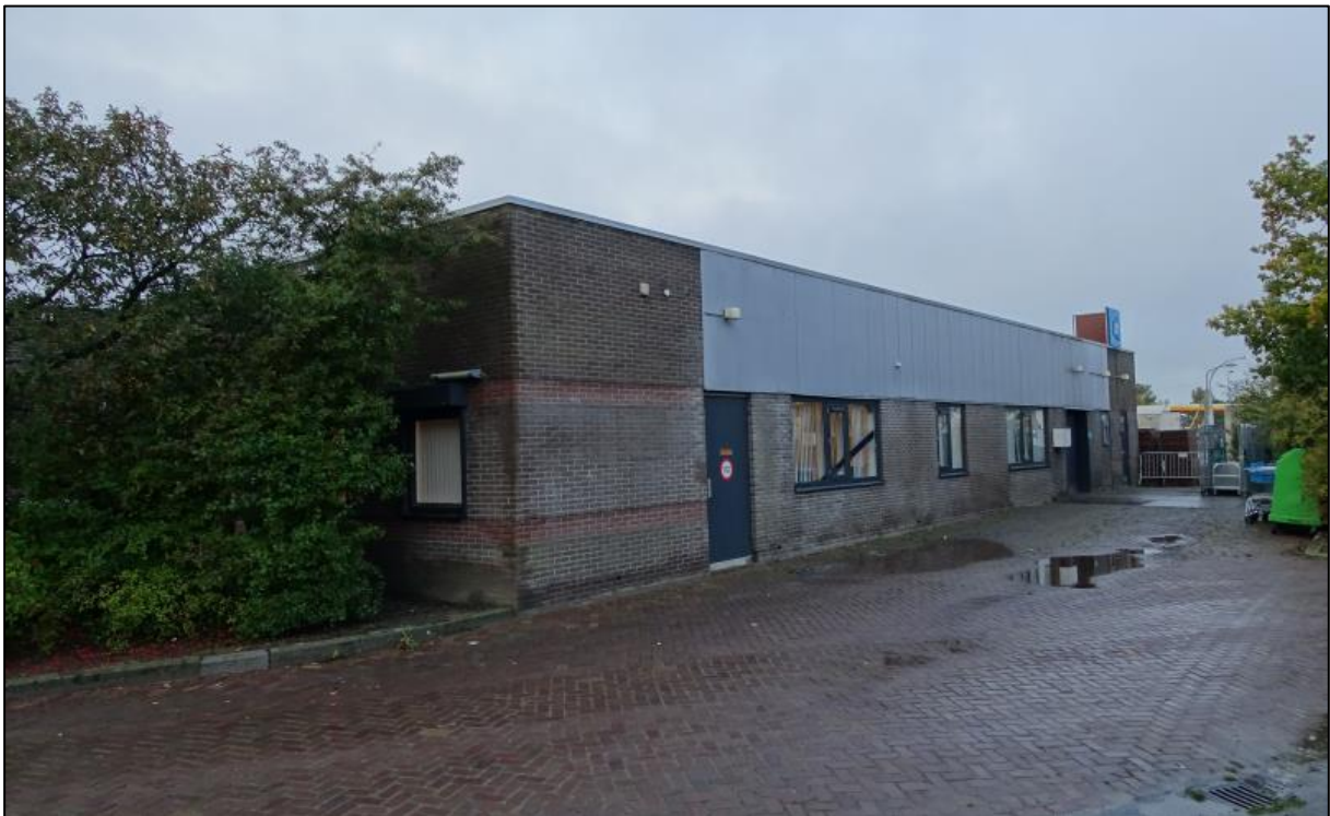
Figuur 2.4. Achterzijde van de Albert Heijn, gezien in zuidwestelijke richting.
