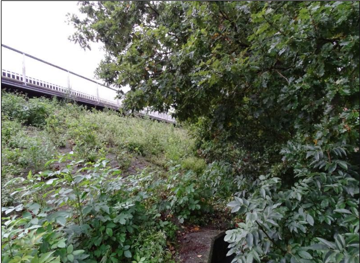
Figuur 2.5. Achterzijde van de bosschages bij het dijkwalud, ten oosten van de Albert Heijn locatie.
