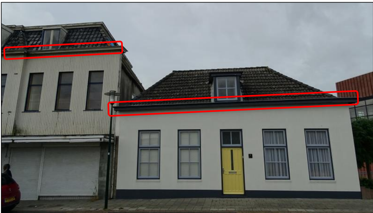
Figuur 5.10. Geschikte nestlocaties voor huismussen onder de eerste rijen met dakpannen.
