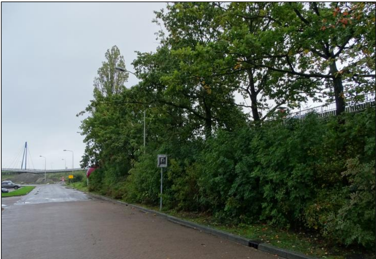
Figuur 5.1. Bosschage aan de Havenstraat tegen het dijktaalud aan, gezien in noordelijke richting.
