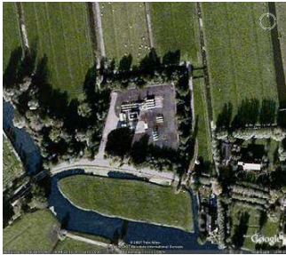
Huidige meet- en regelstation nabij Westeinde te Wijngaarden
