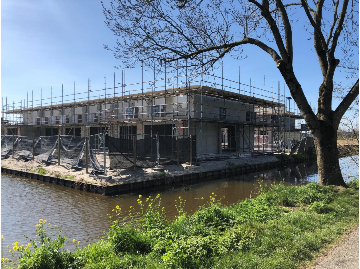
Afbeelding 2.2: Fase 1 in aanbouw (woonveld C1) (april 2020).
