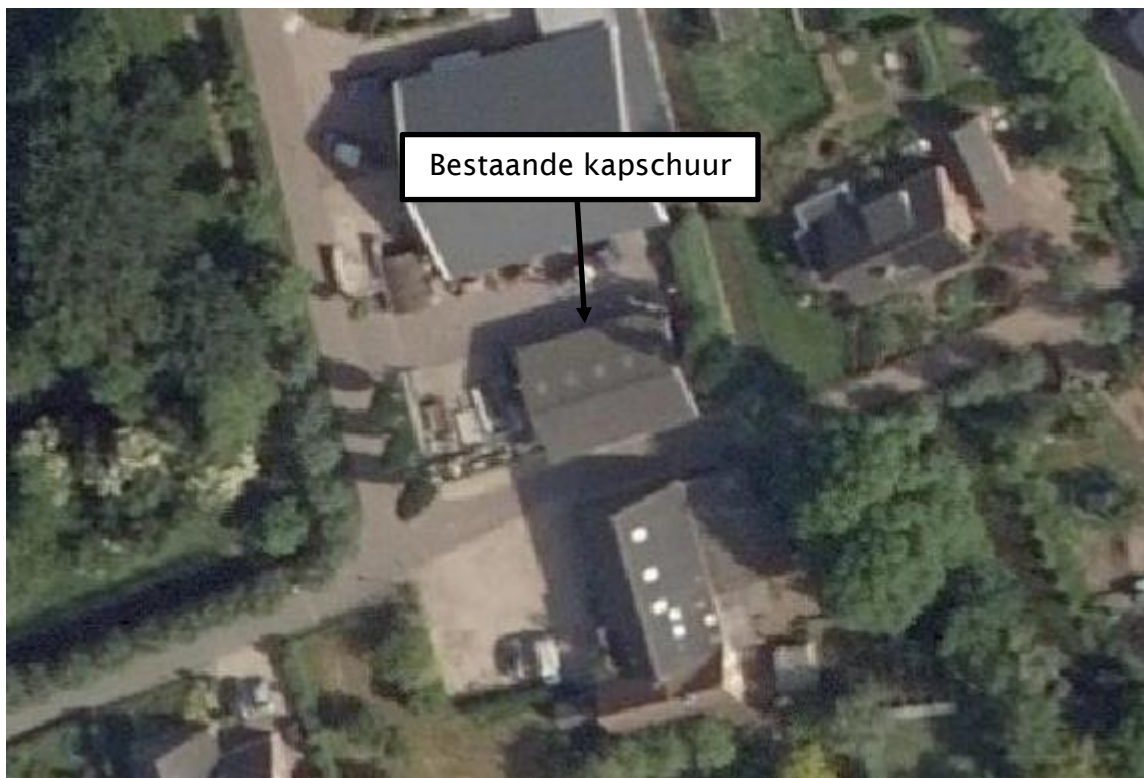
Afbeelding 3: Luchtfoto bestaande situatie
