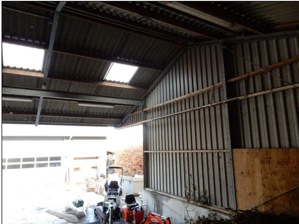
Figuur 4 De kapschuur is opgebouwd uit muren en een dak van metalen damwandplaten.
