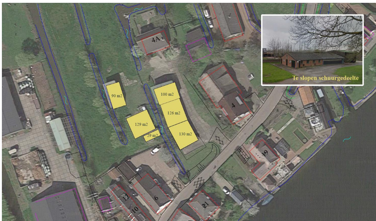
Afbeelding 4: Te saneren bebouwing
