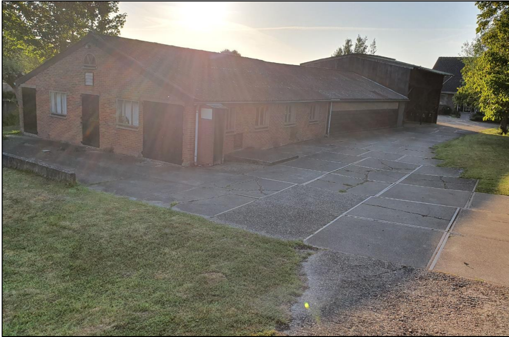
Figuur 1 De planlocatie is gelegen aan de Binnendamseweg 4a te Giessenburg en bestaat uit twee gekoppelde stallen, twee kapschuren, een woning, houtschuur en mestopslag.
