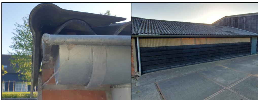
Figuur 4 Windveer van de zuidelijke stal (L) en de potdeksels van de noordelijke stal (R).
