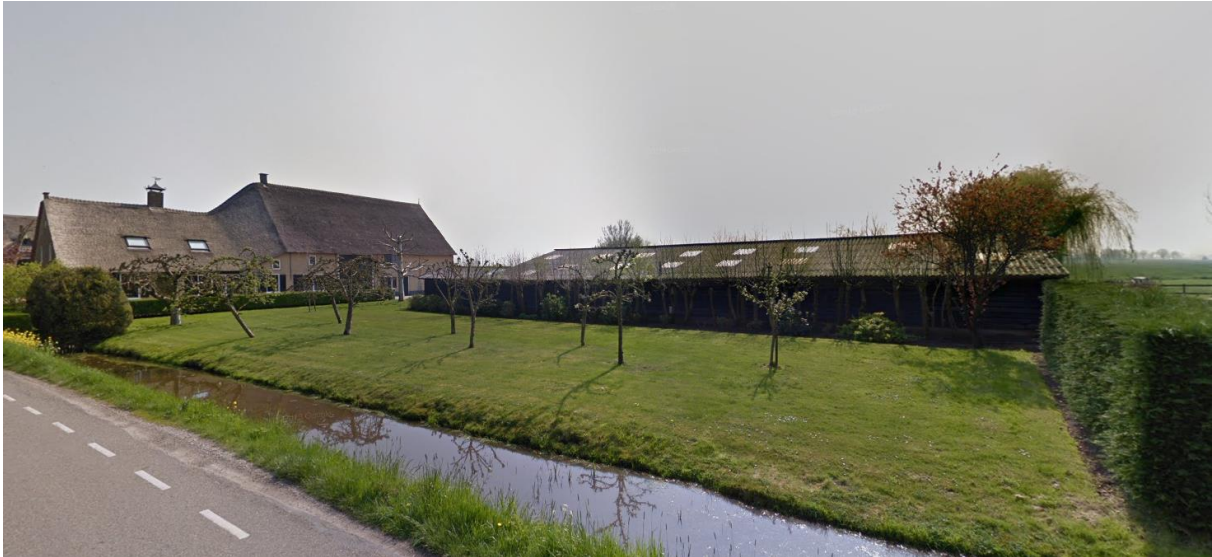
Afbeelding 3: Vooraanzicht voormalige varkensschuur huidige situatie
