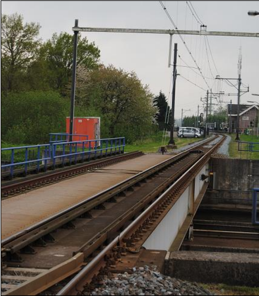
Afbeelding: De spoorbrug over het Merwedekanaal laat geen ruimte voor een geluidsscherm
