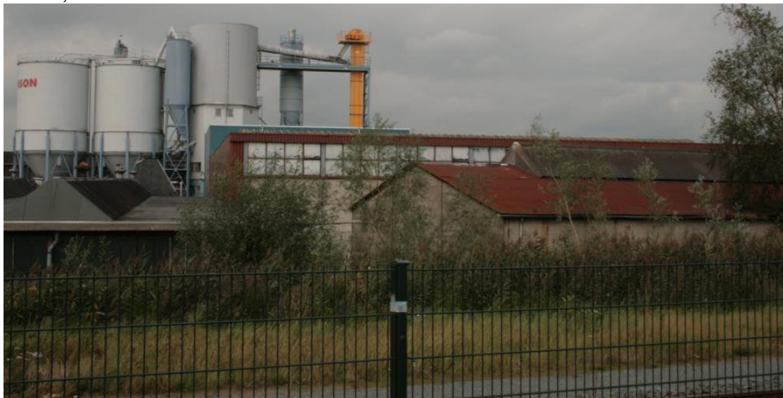
Foto 4, hallen en technische constructies
