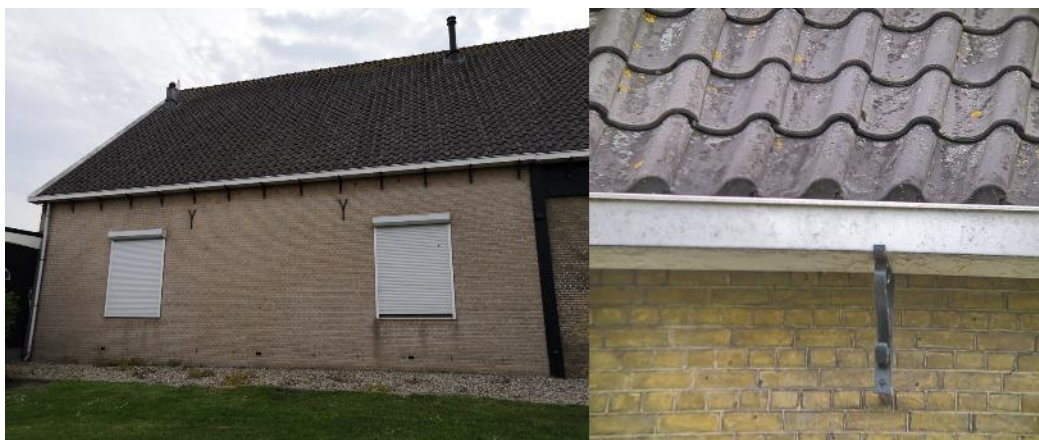
Figuur 5 Er zijn geen scheefliggende of kierende dakpannen aanwezig op het gedeelte van het huis dat mogelijk wordt herbouwd (links). De onderste rij dakpannen op de woning is volledig afgesloten aan de onderkant (rechts).
