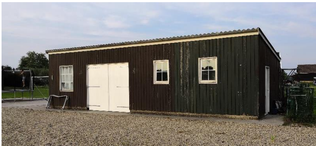
Figuur 3 De houten planken waaruit de kleine schuur is opgebouwd sluiten nauw op elkaar aan. De golfplaten zijn aan de kapse kant volledig afgedicht.
