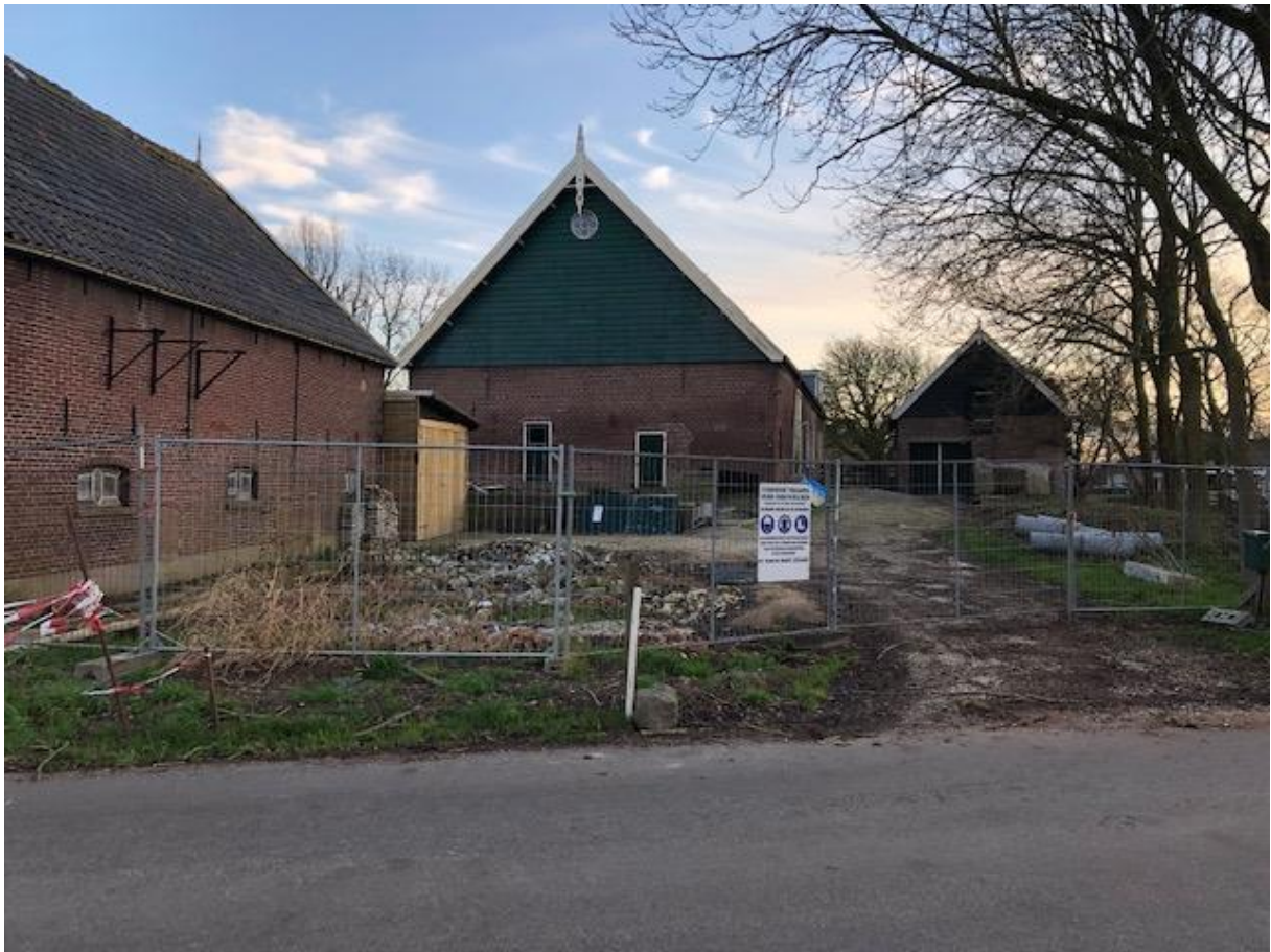
Afbeelding 7: Gesloopte schuur langs de Peperstraat
