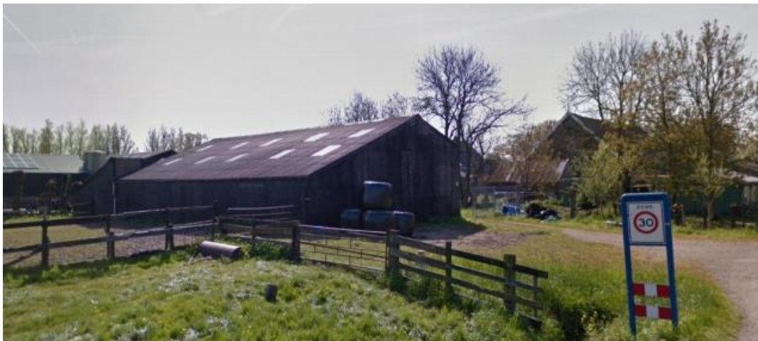
Afbeelding 4: Te slopen agrarische bebouwing Oosteinde 47 Wijngaarden
