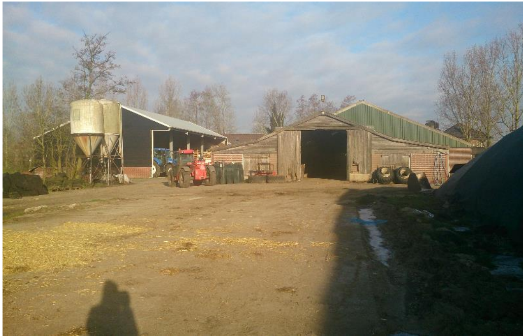
Figuur 1 De slooplocatie is gelegen aan de Heideweg 8 te Giessenburg. Links: een van de twee schuren die gehandhaafd blijft. Rechts: een van de twee stallen die gesaneerd worden.
