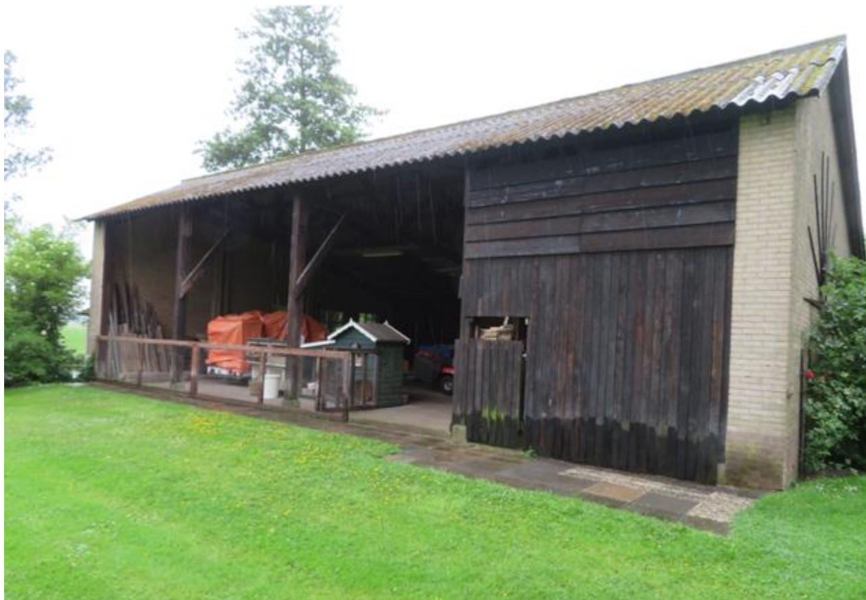
Aanzicht schuur die wordt gesloopt.
