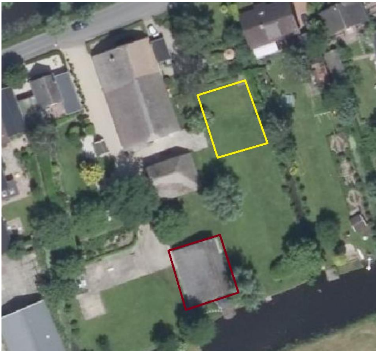
Plangebied: te slopen schuur (rode kader) en stuk gazon waarop een woning komt (gele kader).
