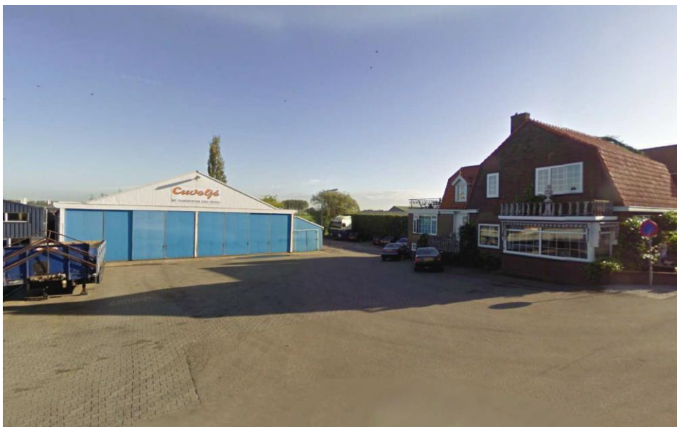
Afbeelding 6: Bestaande situatie Dorpsweg 48 te Hoornaar
