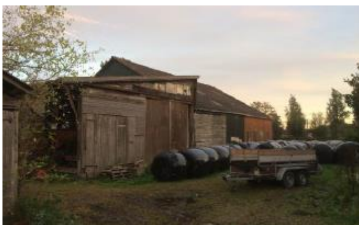
Afbeelding 6: Bestaande bebouwing (deelgebied 1)
