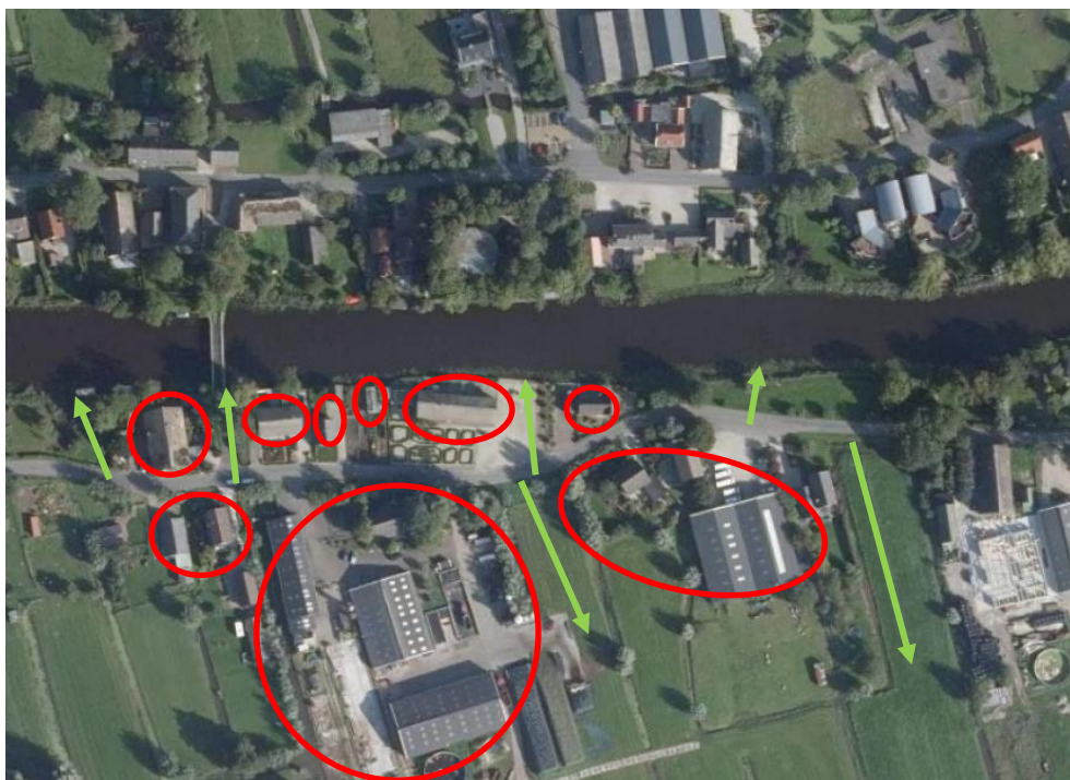
Afbeelding 11: Lintbebouwing met doorzichten
