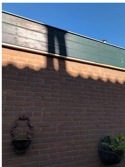
Figuur 11 Dakrand lange zijde schuur
