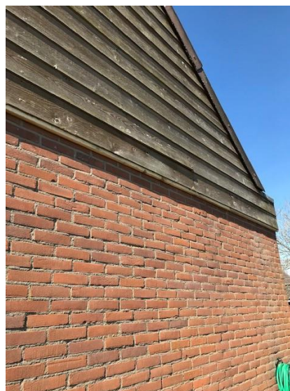
Figuur 10 Dakrand achterzijde schuur
