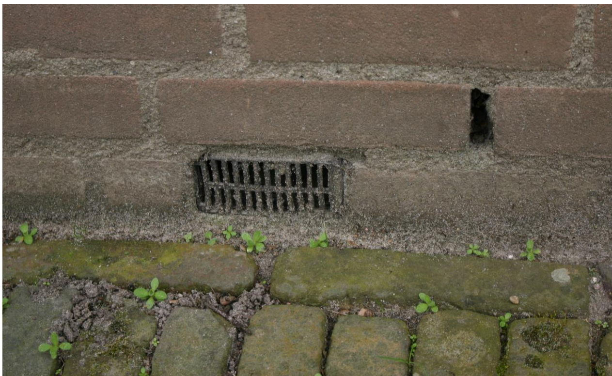
Figuur 4.5.1. Open stootvoegen zijn alleen op enkelhoogte aanwezig in de bebouwing. Overige openingen zijn afwezig dan wel afgedicht (zie foto).
