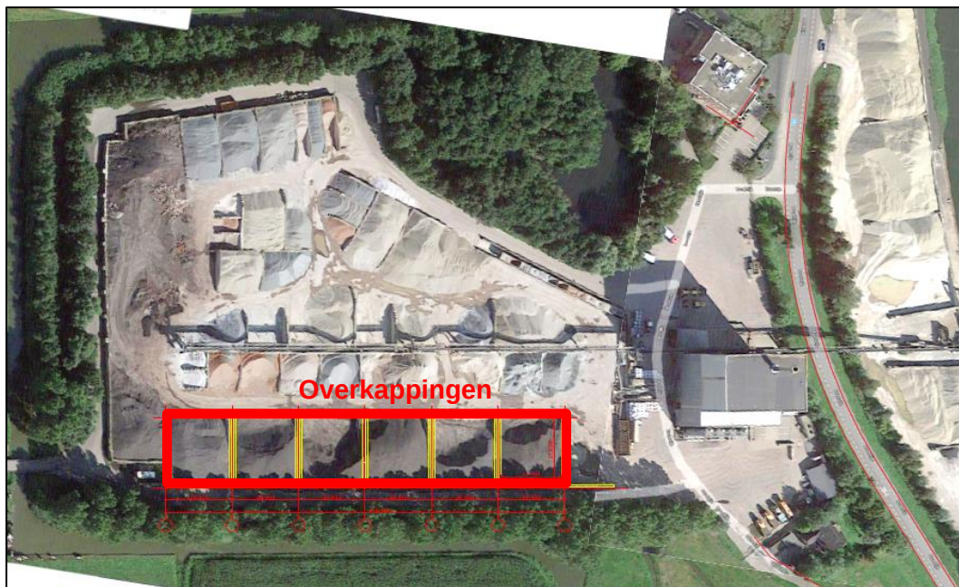
Figuur 2: Zes overkappingen opslagvakken asfaltgranulaat
