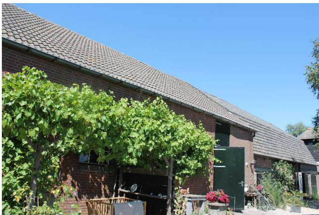
Figuur 1 De planlocatie is gelegen aan de Achterland 4 te Groot-Ammers. Op het perceel zijn een woonboerderij en twee geschakelde schuren gesitueerd. De schuren zijn opgetrokken uit gemetselde muren zonder spouw en hebben een dak (de middelste een zadeldak en de oostelijke schuur een mansardekap) met dakpannen.
