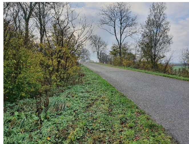
Afbeelding 3 Zicht op verkeer komend vanaf de Witte Brêge is slecht (wintersituatie).
