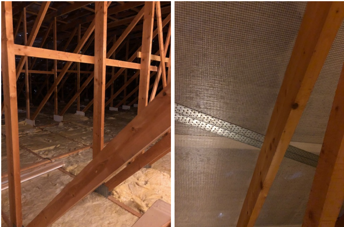
Figuur 5. Voorbeeld van een zolder van een Aldi-supermarkt.
