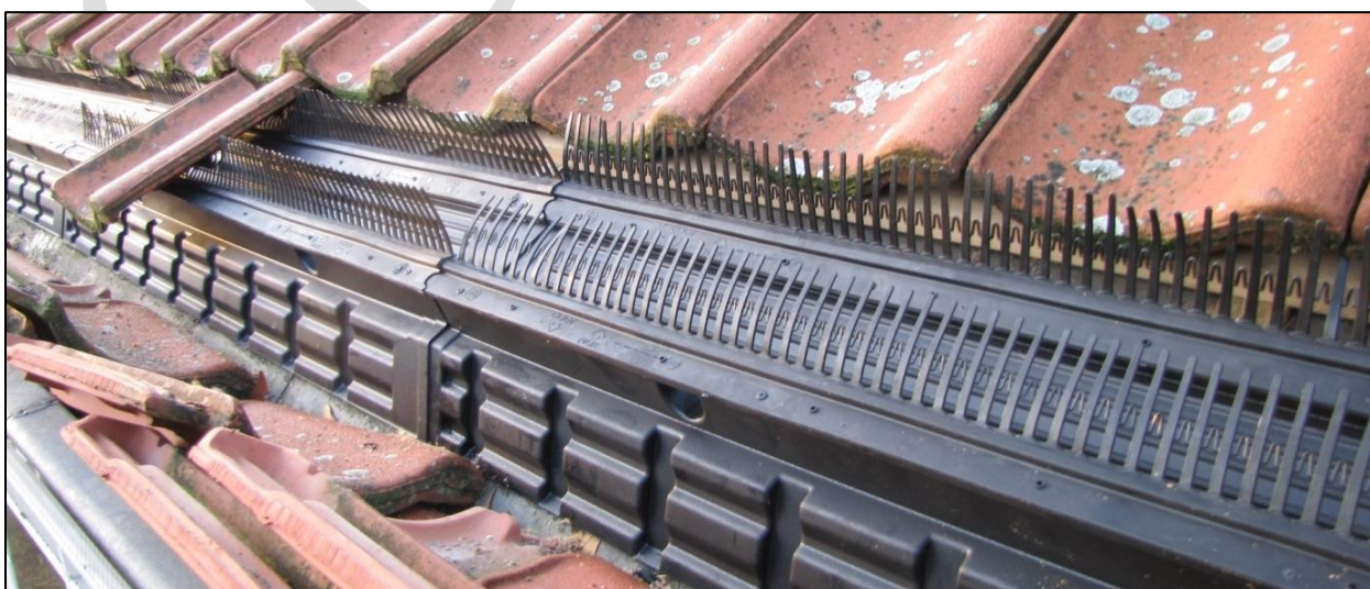
Figuur L2. Voorbeeld van een vogelvide onder de dakpannen.
