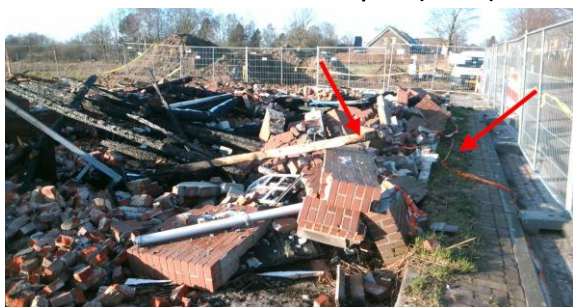
Foto 11. Asbesthoudende restanten plaat (bron 1)
