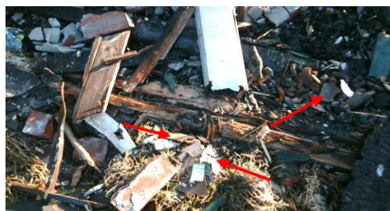
Foto 2. Asbesthoudende restanten plaat (bron 1)
