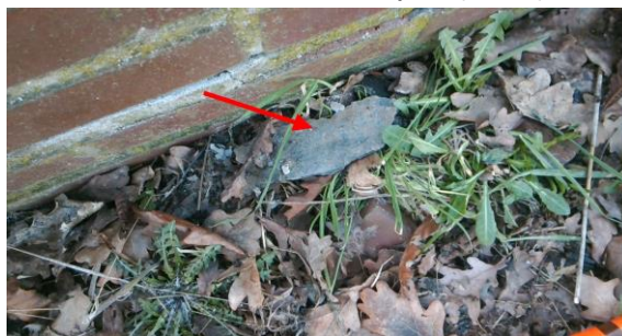
Foto 10. Asbesthoudende restanten plaat (bron 1)
