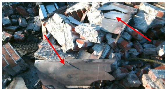
Foto 14. Asbesthoudende restanten plaat (bron 1)
