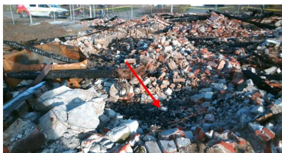
Foto 8. Asbesthoudende restanten plaat (bron 1)
