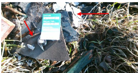
Foto 1. Asbesthoudende restanten plaat (bron 1)
