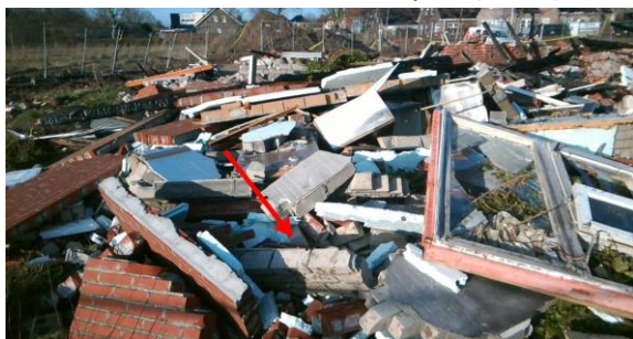
Foto 19. Asbesthoudende restanten plaat (bron 1)
