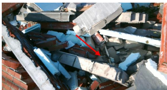
Foto 18. Asbesthoudende restanten plaat (bron 1)
